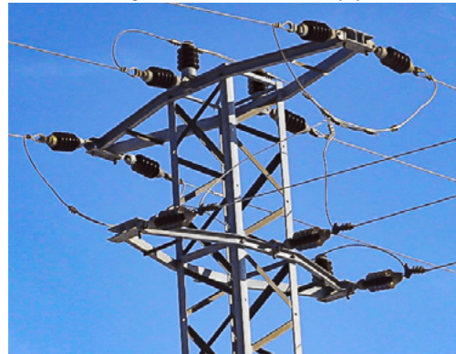
Nejnebezpečnějším typem konstrukce je příhradový sloup. Foto: Václav Hlaváč
